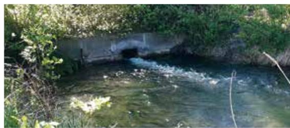
Am „Eimerfass“ in Pottendorf. Das Wasser strömt aus einer quadratischen Öffnung und wird zum Reisenbach. Die Einlassöffnung auf der anderen Seite des Dammes, im Bett der Fischa, ist kreisförmig und entspricht der Fläche eines Eimerfass-Bodens von 0,14 m<sup>2</sup>. (Foto: Christian Mayer)
